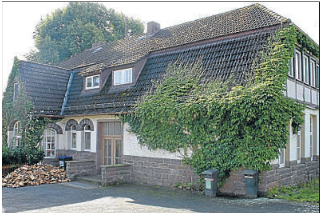
Übernahme: In Eschershausen hat ein Trägerverein die alte Schule übernommen, die als Dorfgemeinschaftshaus genutzt wird. Archifoto: Dumnitz
